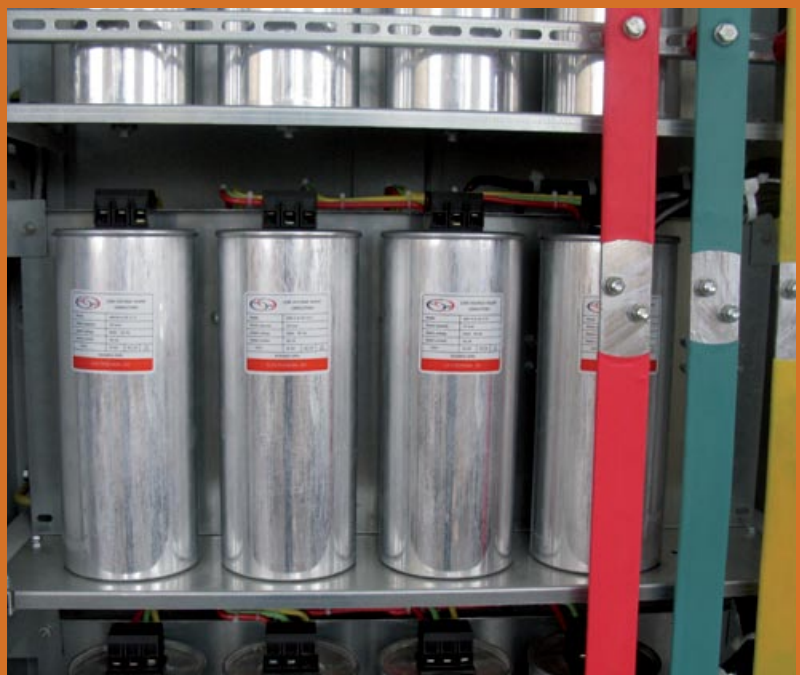
КРМ-0,4 (блок конденсаторов)
