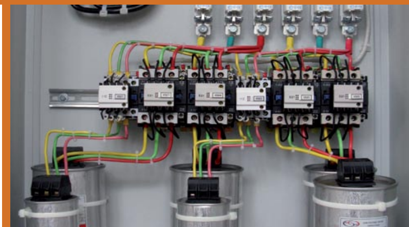
КРМ-0,4 (блок контакторов)
